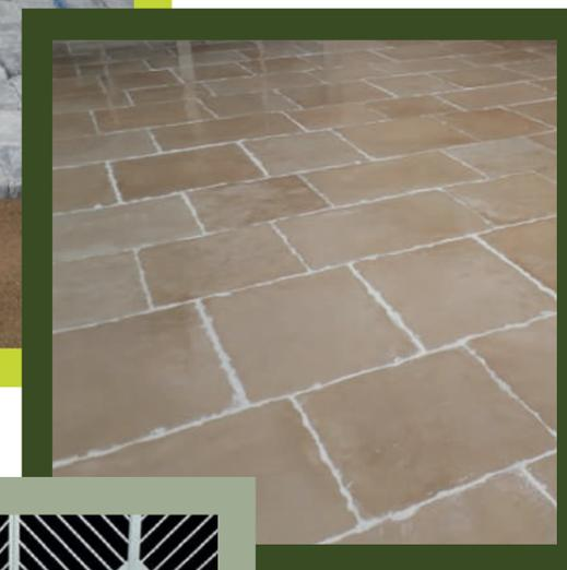
Pose de dalles en béton reconstituées sur sable.
